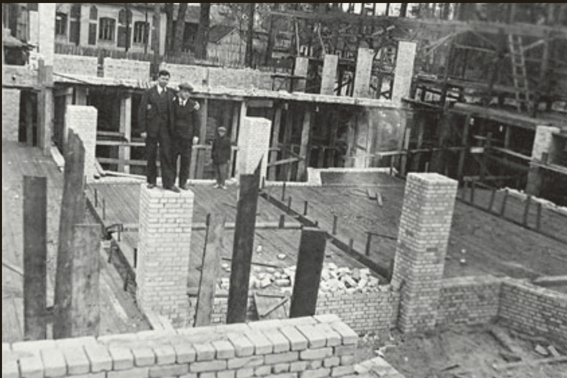
Борис Смирнов и Борис Крейцер на стройплощадке кинотеатра в г. Бежице. 1936 год
