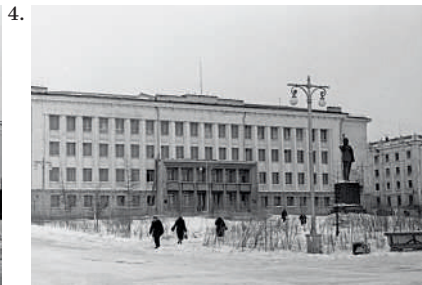
4. Здание Главного управления Дальстроя в Магадане. 1942 год
