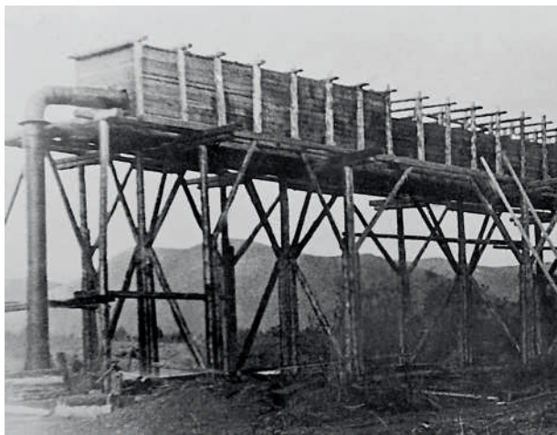
3, 4, 5. Гидроэлеватор на прииске «Верхний Ат-Урях». 1942 год
