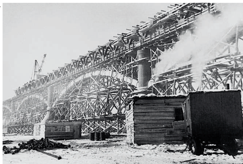
4. Строительство моста через реку Колыму. Вид на левый берег: подсобные постройки на льду, компрессорная. Вблизи поселка Дебин. 1953 год
